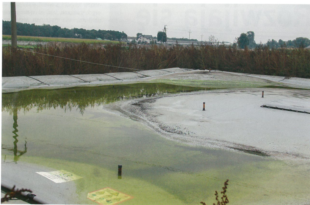
Poferment z reaktora trafia do laguny, z której jest wywożony na pole.
