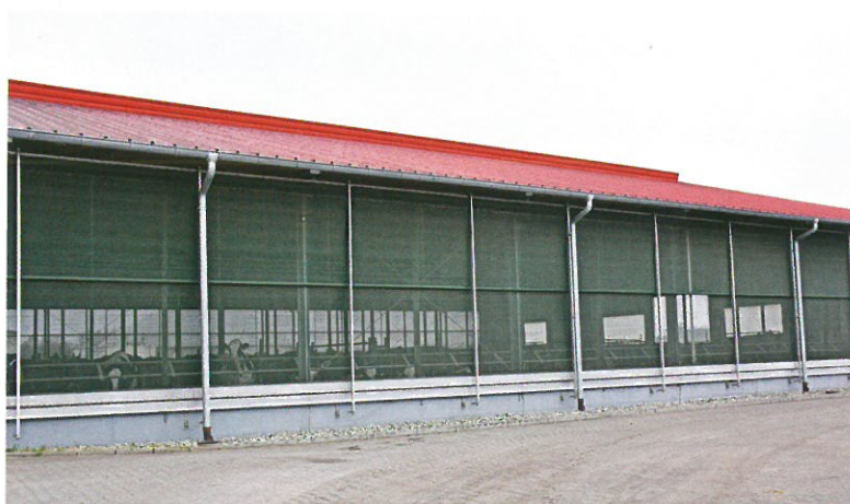
Kurtyny ścienne są wysokie prawie na 5 m, a cokół pod nimi ma zaledwie wysokość 70 cm
