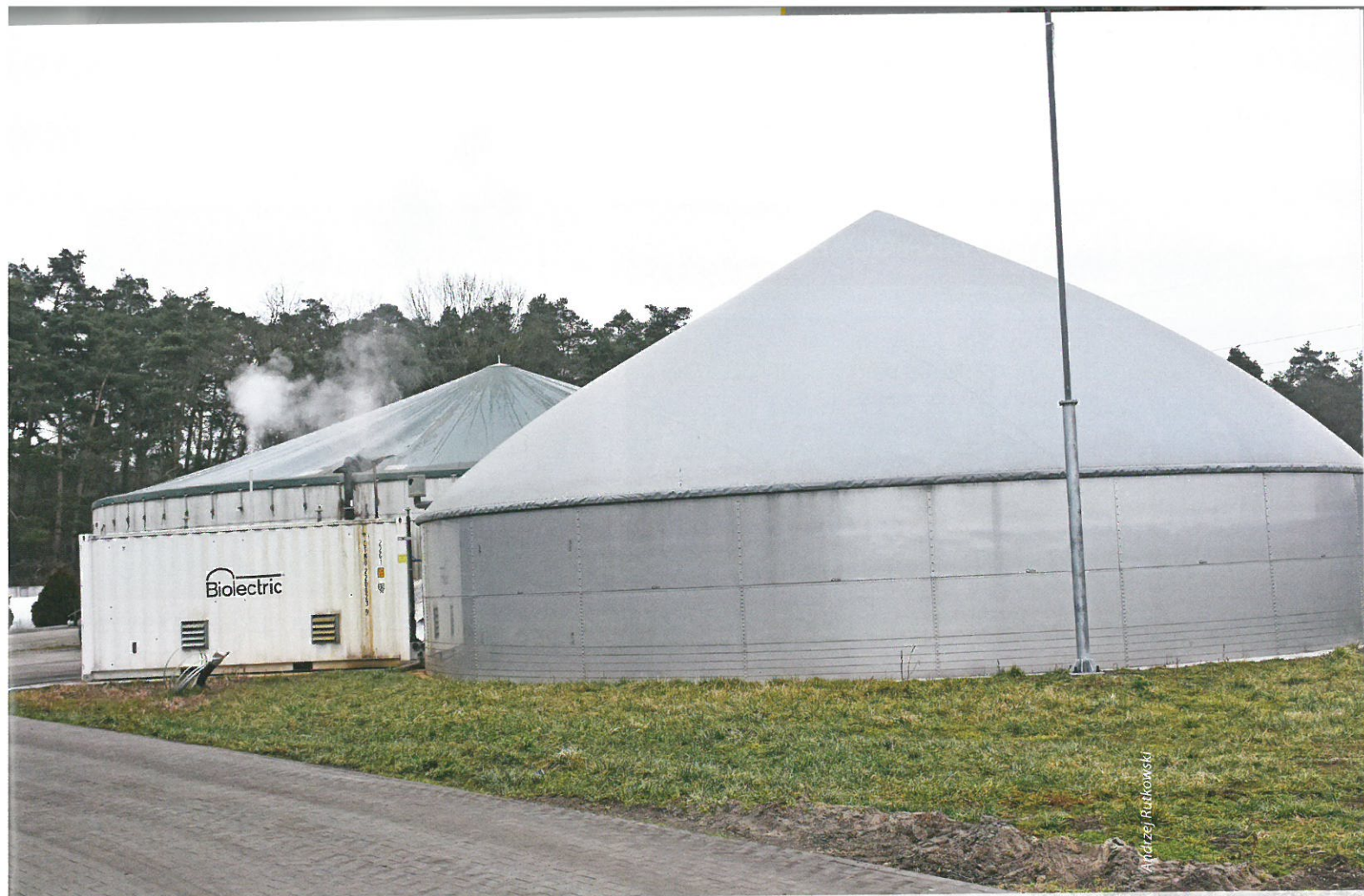
Biogazownia, w której substratem jest gnojowica
